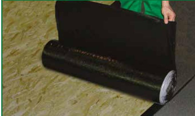
Nella famiglia delle membrane Superadesive, la gamma SELFTENE si distingue perché è costituita da una serie specifica di membrane ed accessori, corredata da apposite istruzioni d'uso, selezionata per una posa semplice, senza impiego di attrezzature professionali e utilizzando una gamma ridotta di prodotti, per la soluzione dei più comuni problemi di impermeabilizzazione dei tetti in legno.
