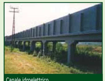
Canale idroelettrico Hydroelectric generating stations Piemonte - Italia
