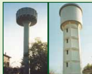
Torri Piezometriche - Piezometric towers Bologna - Italia
