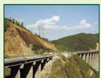
Viadotto "Hemus" - Bulgaria
