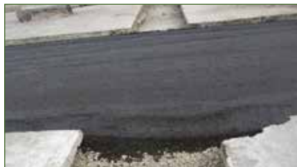
Le corsie sono attraversate da una trincea dove si alloggiavano gli impianti
