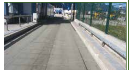
Stesura di AUTOTENE ASFALTICO ANTIPUMPING HE/TVP
