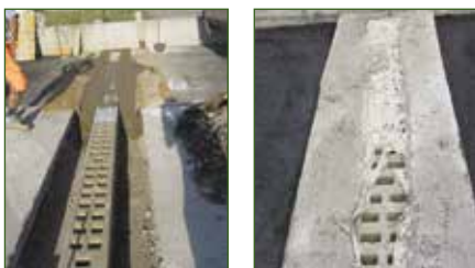
Il canale viene bloccato da un getto di cls
