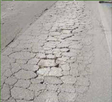
Coccodrillatura profonda che si stacca a scaglie, strutturalmente inadeguata
