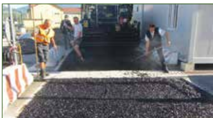
Stesura a caldo di un conglomerato aperto
