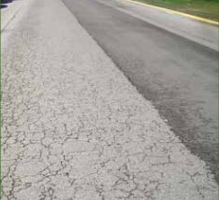
Coccodrillatura profonda che si stacca a scaglie, strutturalmente inadeguata
