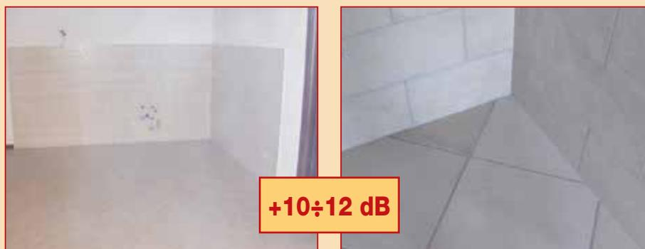
Il **battiscopa** rigidamente connesso con il pavimento o il pavimento rigidamente connesso alle pareti, può comportare penalizzazioni dipendenti dalla superficie del contatto, tali penalizzazioni sull'indice  $L'_{n,w}$  possono arrivare a superare i 20 dB.
