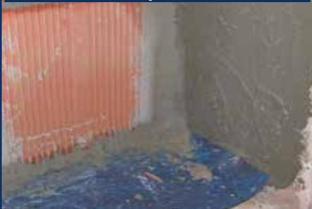
guarnizioni perimetrali elastiche con buone caratteristiche di resistenza alla compressione e di adesione a tutti i tipi di supporto, mantenendo nel tempo le doti di elasticità. L'adesione fornita da FONOPLAST è nettamente superiore a quella di una comune malta di cantiere.
