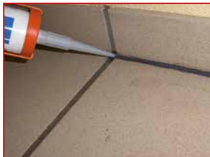
**Giunti in corrispondenza delle soglie.** Altrettanto importante è la cura che si deve porre in prossimità delle marmette di soglia delle porte e delle porte-finestra di accesso al locale al fine di evitare il collegamento della pavimentazione con malta rigida; si dovrà invece lasciare in loco il FONOCCELL fino alla conclusione della posa del pavimento che sarà poi rimosso e sostituito con un profilo di materiale morbido ed elastico.
