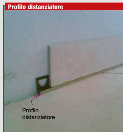
**Sigillatura elastica.** Dopo aver posato il battiscopa o il rivestimento ceramico staccato dalla pavimentazione si potrà disporre un cordolo di sigillatura elastica. *Anche in questa ultima fase è da evitare la creazione di contatti rigidi con il pavimento che causerebbe un ponte acustico che penalizzerebbe l'isolamento.*
