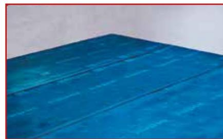
**Sigillatura dei teli.** Successivamente tutte le linee di sovrapposizione longitudinale e le linee di accostamento trasversale saranno accuratamente sigillate con l'apposito nastro adesivo SIGILTAPPE incollato a cavallo delle stesse.
