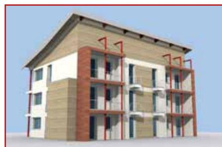
A seguito del primo collaudo effettuato dal nostro ufficio tecnico, eseguito sulle strutture al grezzo senza nessun rivestimento ne controsoffitto (il valore dell'indice di calpestio normalizzato misurato è stato di 84 dB come indicato nel rapporto di prova riportato), sono state concertate due diverse soluzioni per le due tipologie costruttive: doppio strato di FONOSTOPDuo per la stratigrafia "a umido" e FONOSTOPLegno per la stratigrafia "a secco".
