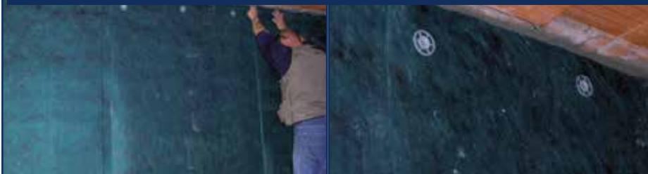
**3. Parete completamente rivestita e pronta per la posa del materiale fibroso tipo SILENTRock o SILENTEco.**
