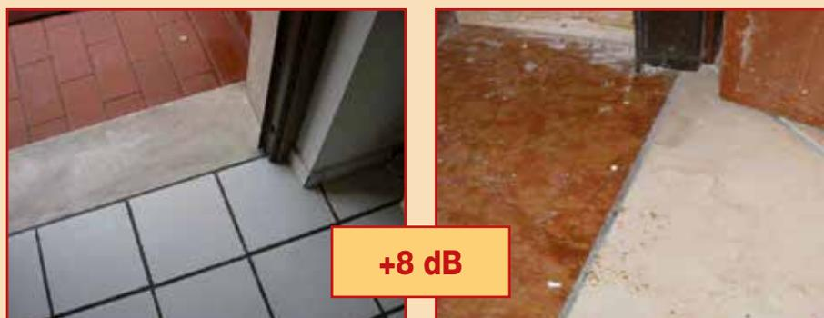
Il **rivestimento** dell'angolo cottura del soggiorno rigidamente connesso con il pavimento, può comportare penalizzazioni dipendenti dalla superficie del contatto, tali penalizzazioni sull'indice  $L'_{n,w}$  possono arrivare anche a 12 dB.
