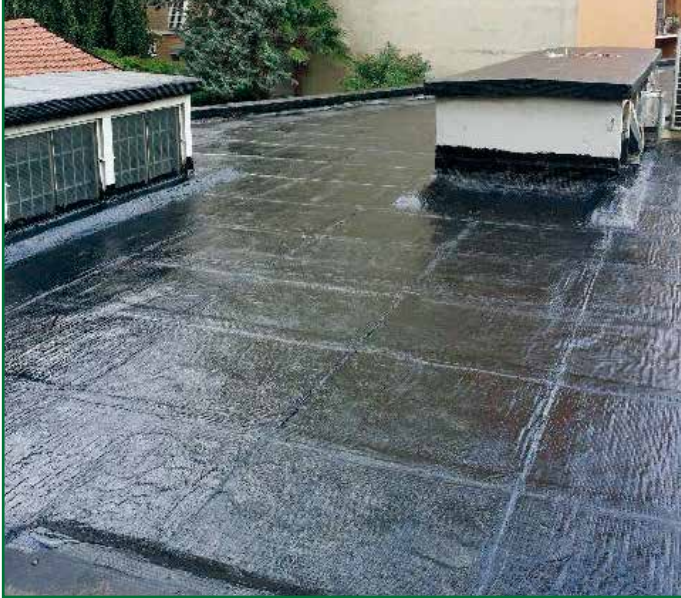
RINNOVAMENTO DI UN MANTO IMPERMEABILE ESISTENTE APPLICANDO UNA MANO DI PURLASTIC FLASHING
