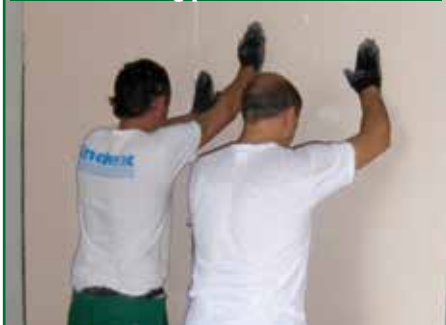
Posizionamento di un altro pannello di TOPSILENTDuogips
