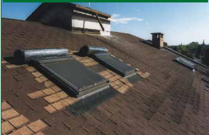
PRIMA: COPERTURA CON VECCHIE TEGOLE BITUMINOSE
