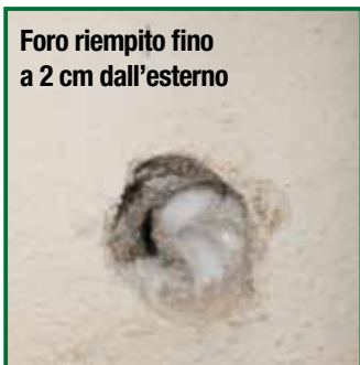
Stuccatura con malta cementizia rapida (tipo FASTCEM)
