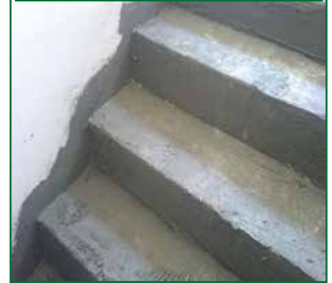
FONOPLAST impiegato sui gradini per l'attenuazione dei rumori delle scale
