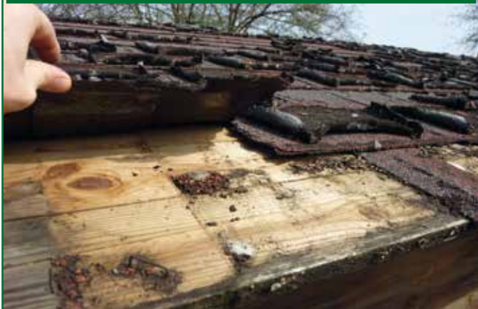
PRIMA: COPERTURA CON VECCHIE TEGOLE BITUMINOSE
