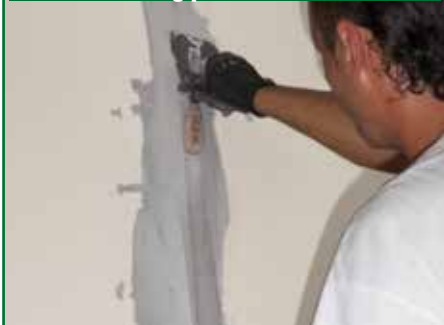
Sigillatura tra i pannelli di TOPSILENTDuogips
