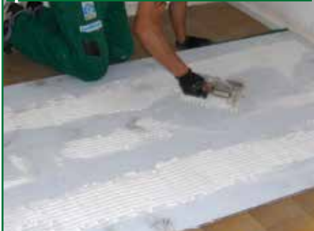
Sigillatura tra i pannelli di TOPSILENTDuogips
