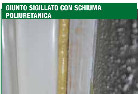
GIUNTO SIGILLATO NUOVAMENTE CON FONOELAST MONO
