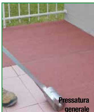
Rimozione del film siliconato
