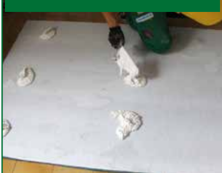
Posizionamento di un altro pannello di TOPSILENTDuogips
