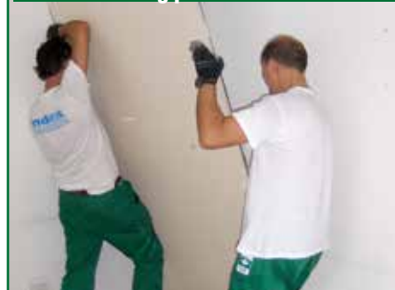
Posizionamento del pannello di TOPSILENTDuogips
