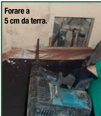
Forare dove possibile. Attenzione agli impianti!
