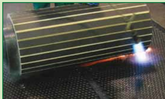
4 Posa a fiamma di THERMOBASE TEGOLA
