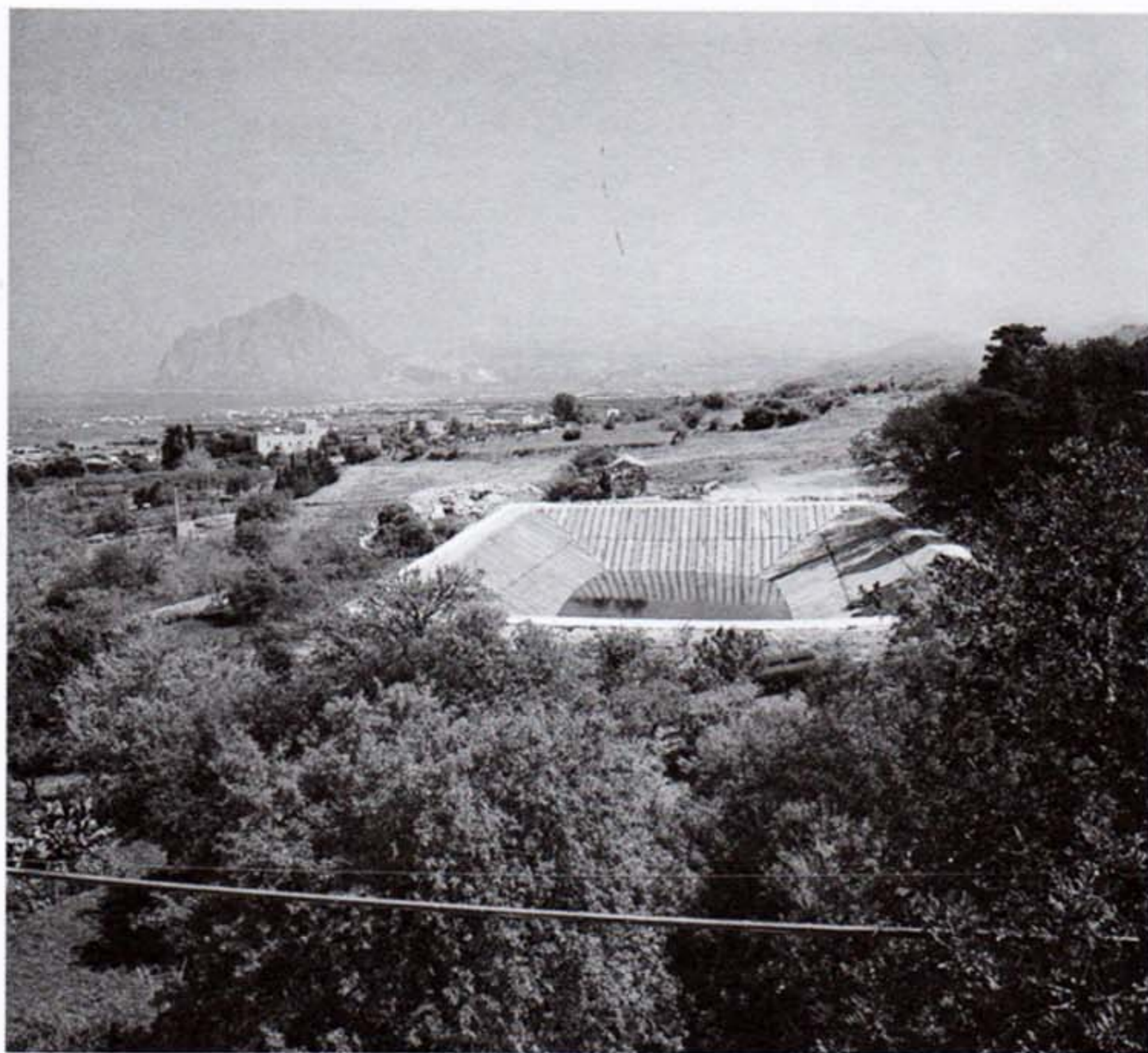
Bacino idrico contro terra. Opera ultimata.
