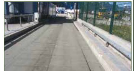
Laying AUTOTENE ASFALTICO ANTIPUMPING HE/TVP
