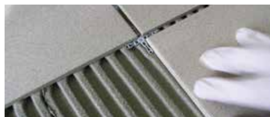
Su UNOLASTIC è possibile posare piastrelle utilizzando adesivi C2S1
