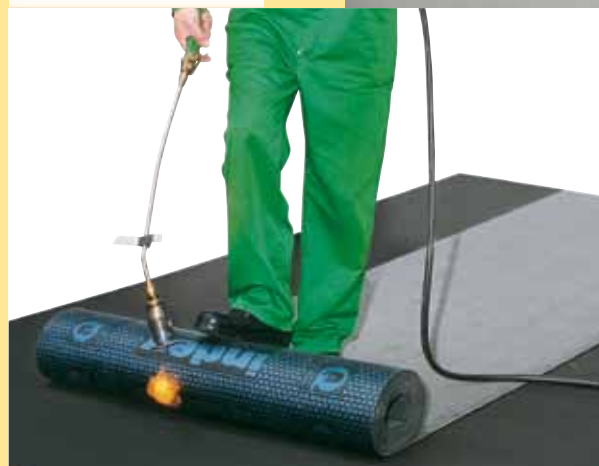
NUOVO SISTEMA DI POSA A FIAMMA
