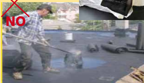
VECCHIO SISTEMA DI POSA CON SPALMATURE DI BITUME (2006, tetto USA)
