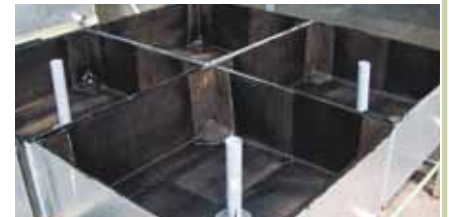
2. Vasche di prova impermeabilizzate
