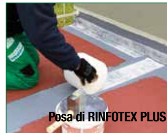
Posa di RINFOTEX PLUS
