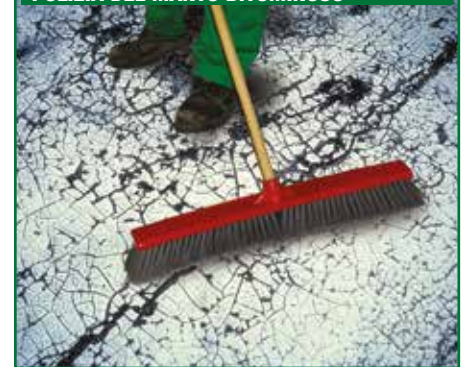
PULIZIA DEL MANTO BITUMINOSO
