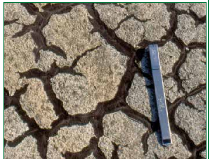
COCCODRILLATURA DI SUPERFICIE BITUMINOSE ARDESiate PER ECCESSO DI SPESSORE DI BITUME SULL'ARMATURA, MA DOPO 30 ANNI IL MANTO È ANCORA A TENUTA D'ACQUA
