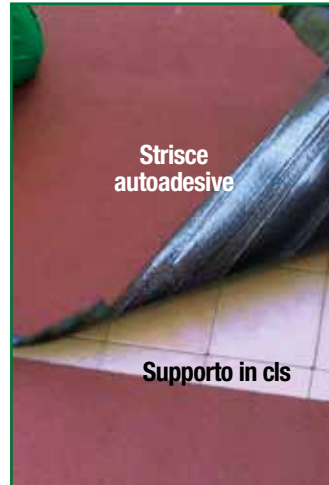
Rimozione del film siliconato
