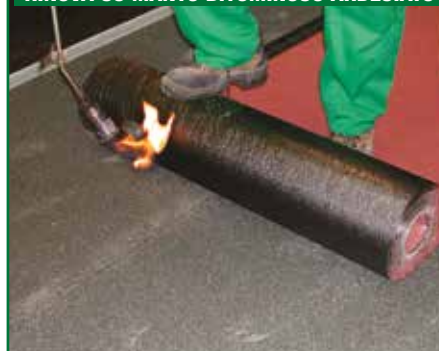
APPLICAZIONE DI MINERAL TECTENE RINOVA SU MANTO BITUMINOSO ARDESIATO
