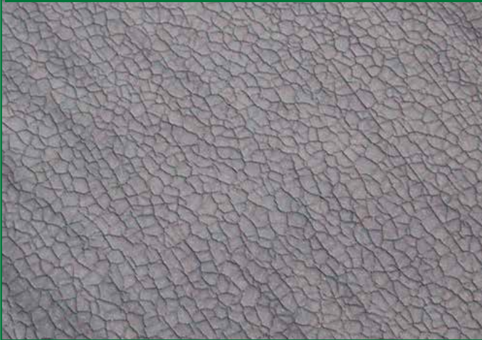
COCCODRILLATURA DI SUPERFICIE BITUMINOSE ARDESiate PER ECCESSO DI SPESSORE DI BITUME SULL'ARMATURA, MA DOPO 30 ANNI IL MANTO È ANCORA A TENUTA D'ACQUA
