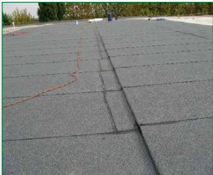
RITIRO A CALDO DELLE GIUNZIONI DI TESTA DI MEMBRANE ARMATE CON TNT DI POLIESTERE, IL FENOMENO INTERESSA OGNI FOGLIO SINGOLARMENTE
