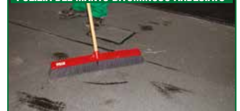
PULIZIA DEL MANTO BITUMINOSO ARDESIATO
