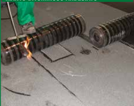
APPLICAZIONE DI TECTENE REROOF SU MANTO BITUMINOSO ARDESIATO
