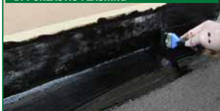
7. SECONDA MANO DI PURLASTIC FLASHING
