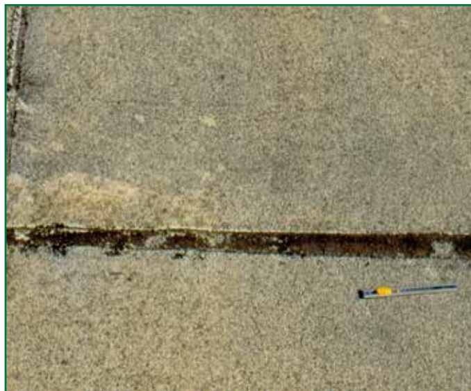
RITIRO A CALDO DELLE GIUNZIONI DI TESTA DI MEMBRANE ARMATE CON TNT DI POLIESTERE, IL FENOMENO INTERESSA OGNI FOGLIO SINGOLARMENTE
