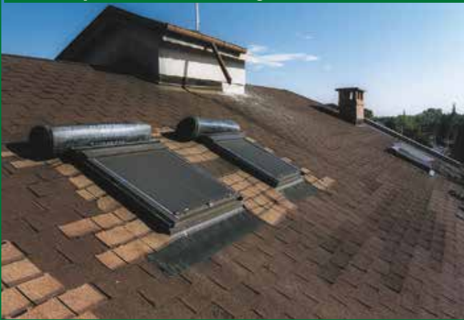
Prima: copertura con vecchie tegole bituminose
