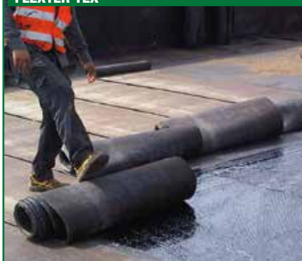
5. POSA DELL'ARMATURA RINFOTEX EXTRA
