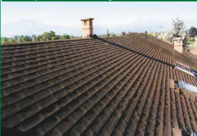
Prima: copertura con vecchie tegole bituminose
