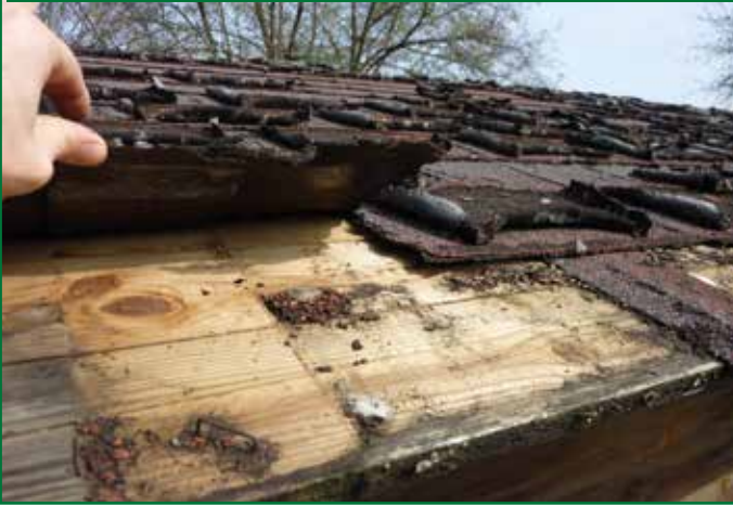
Prima: copertura con vecchie tegole bituminose
