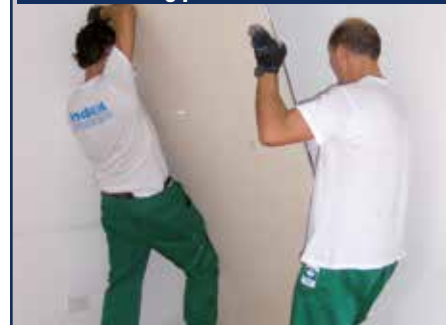
3. Posizionamento del pannello di TOPSILENTDuo gips
