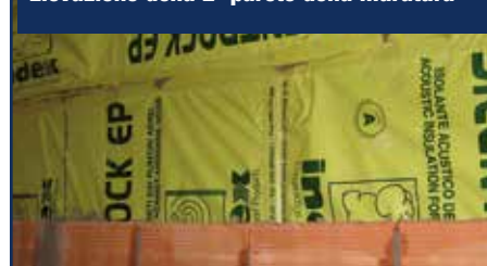
Elevazione della 2ª parete della muratura
