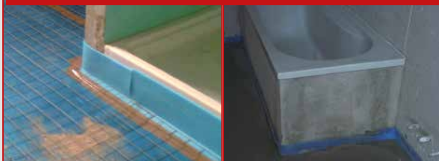
Distacco dei massetti del piatto doccia e della vasca con l'interposizione di FONOCCELL
