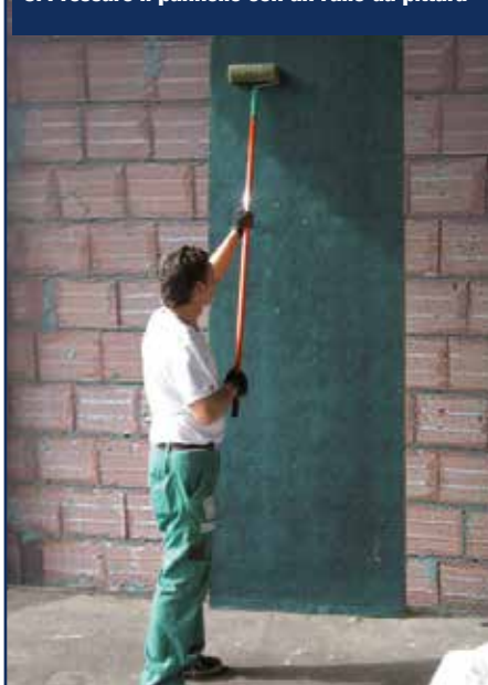
5. Pressare il pannello con un rullo da pittura
