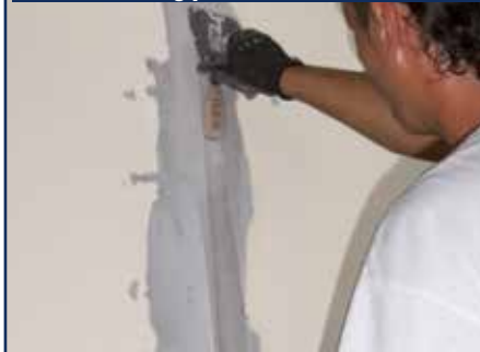
5. Sigillatura tra i pannelli di TOPSILENTDuo gips
