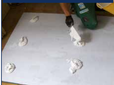
4. Posizionamento di un altro pannello di TOPSILENTDuo gips
