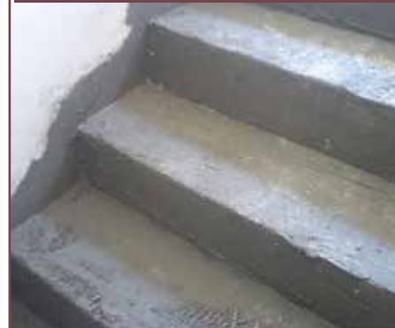
FONOPLAST impiegato sui gradini per l'attenuazione dei rumori delle scale
