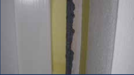
Giunto sigillato nuovamente con FONOELAST MONO
