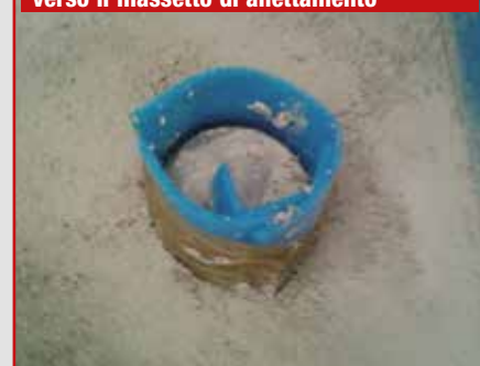
Desolidarizzazione dello scarico idrico verso il massetto di allettamento
