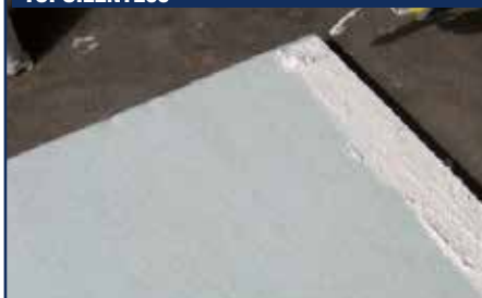
5. Pressare il pannello con un rullo da pittura
