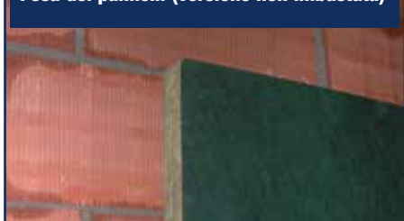
Posa dei pannelli (versione non imbustata)
