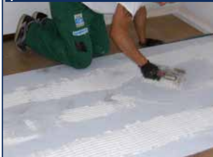
5. Sigillatura tra i pannelli di TOPSILENTDuo gips
