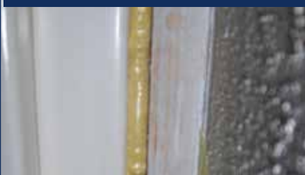
Giunto sigillato nuovamente con FONOELAST MONO
