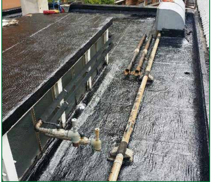
RINNOVAMENTO DEL MANTO IMPERMEABILE ESISTENTE APPLICANDO UNA MANO DI PURLASTIC FLASHING
