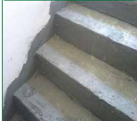
FONOPLAST impiegato sui gradini per l'attenuazione dei rumori delle scale
