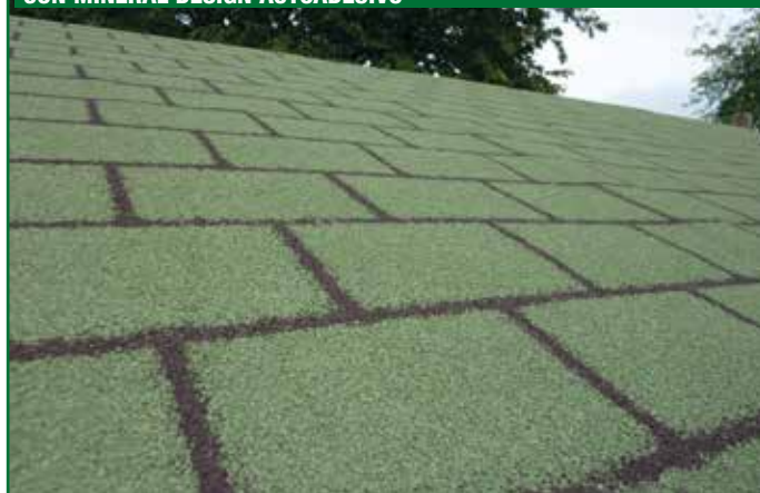
DOPO: TEGOLE RIMOSSE E SOSTITUITE CON MINERAL DESIGN AUTOADESIVO
