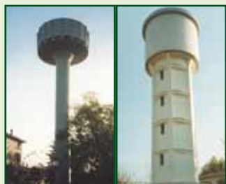
Torri Piezometriche - Piezometric towers Bologna - Italia
