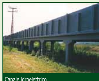
Canale idroelettrico Hydroelectric generating stations Piemonte - Italia
